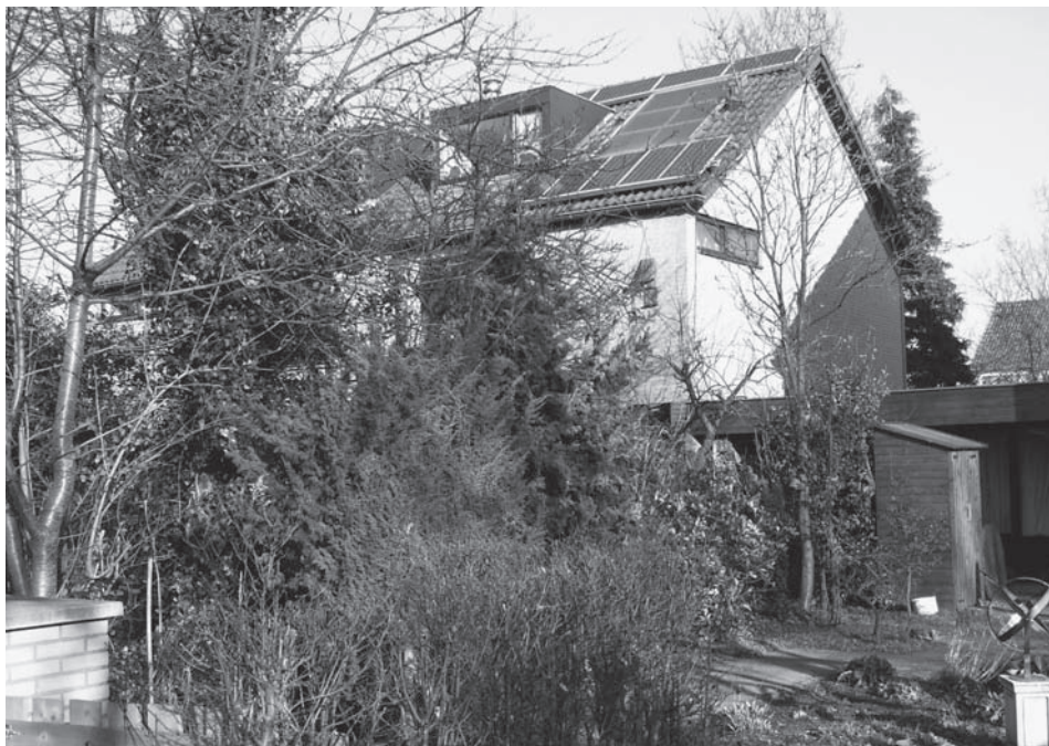
De voorkant van 'het verduurzaamde huis' in Boxtel, met natuurrijke tuin en op het dak een zonnecollector van 4 m 2 voor warm water en 9 zonnepanelen voor de stroomvoorziening.
